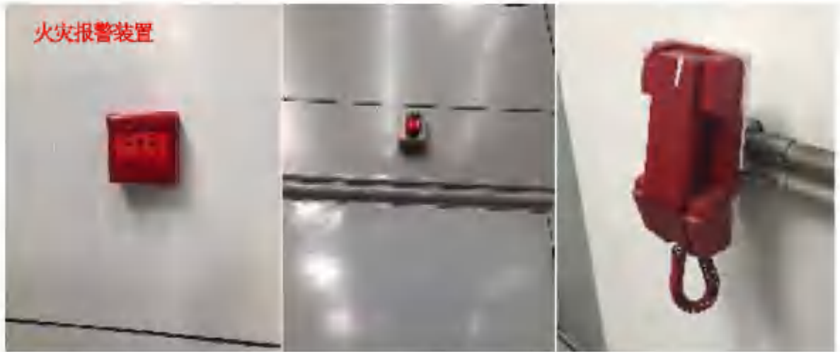
图 4-9 风险防范措施落实情况
