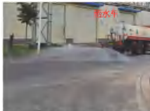
图 4-6 无组织废气治理措施落实情况
